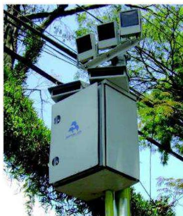
Todo o processo de medição e cálculo de velocidade é realizado por circuitos eletrônicos específicos, responsáveis por enviar os valores dos registros previamente determinados a um microcomputador. Esta máquina, por sua vez, armazena os dados recebidos destes circuitos eletrônicos específicos assim como comanda os registros fotográficos dos veículos.
