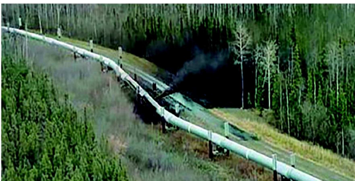
Vazamento em Oleoduto
